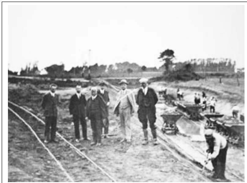
De aanleg van het kanaal was voor een belangrijks deel een werkverschaffingsproject, Er was nauwelijks sprake van mechanisatie en het kanaal werd voor een groot deel met de hand uitgegraven.
