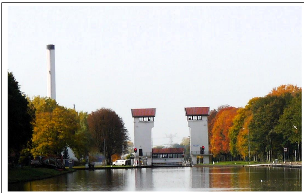
Het Sluiscomplex De Waarbeek in Hengelo. Foto: SCEE ©
