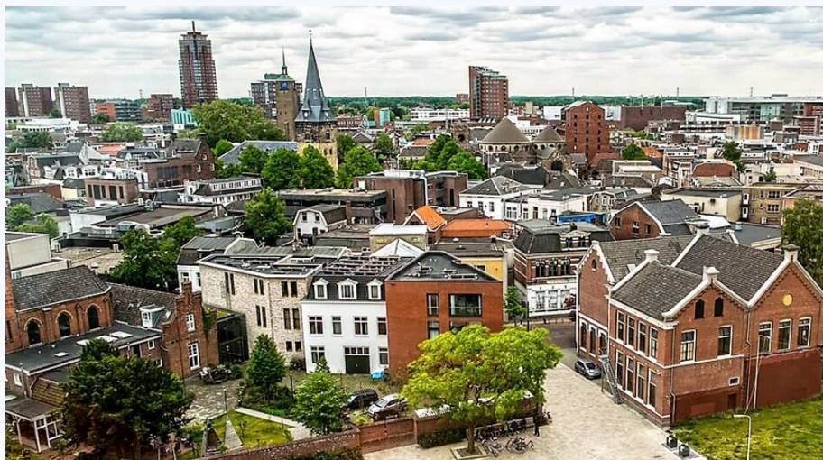
Rechts onder de voormalige Fabrieksschool aan de Noorderhagen die voorzien is van zonnepanelen. Foto: SCEE
