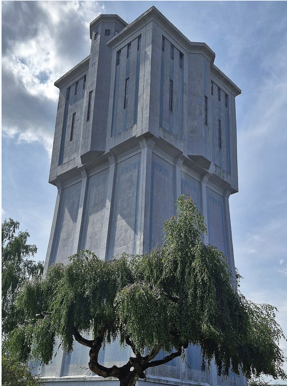
De watertoren aan de Reggestraat 7 in Almelo.
