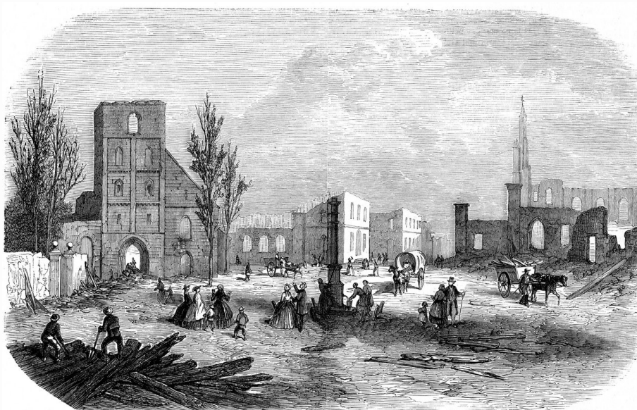
De torenspits was samen met de klokken volledig ingestort. Het archief van de gemeente Enschede bevond zich in de toren en werd eveneens vernietigd.
