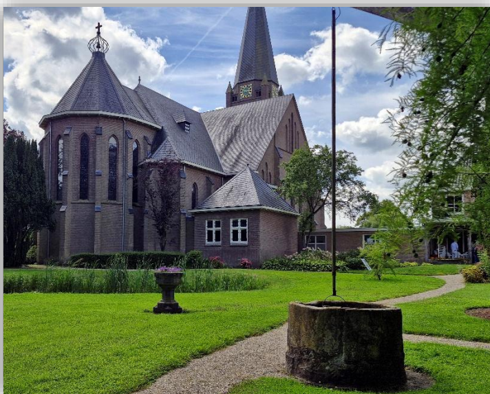
De waterput die met uitzondering van de bovenbouw nog origineel is.
