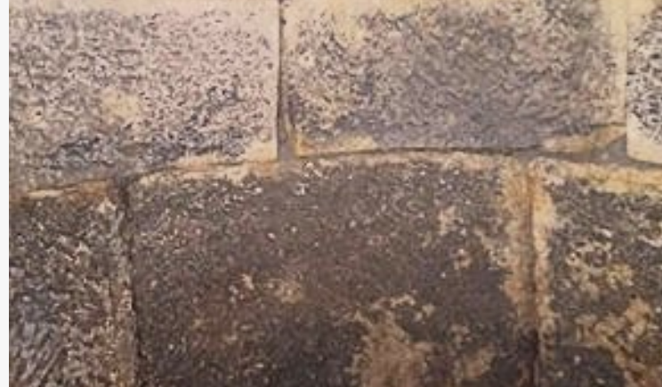
De binnenwand van de waterput
