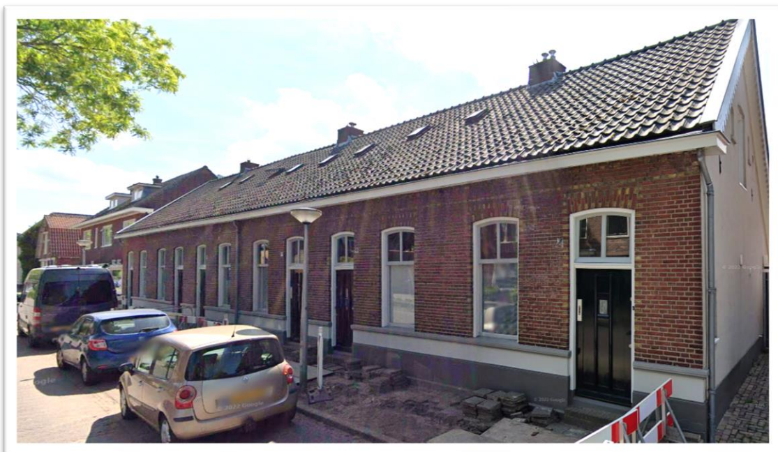
De gemeenschappelijk gerenoveerde afdakswoningen aan de Sumatrastraat 71.
