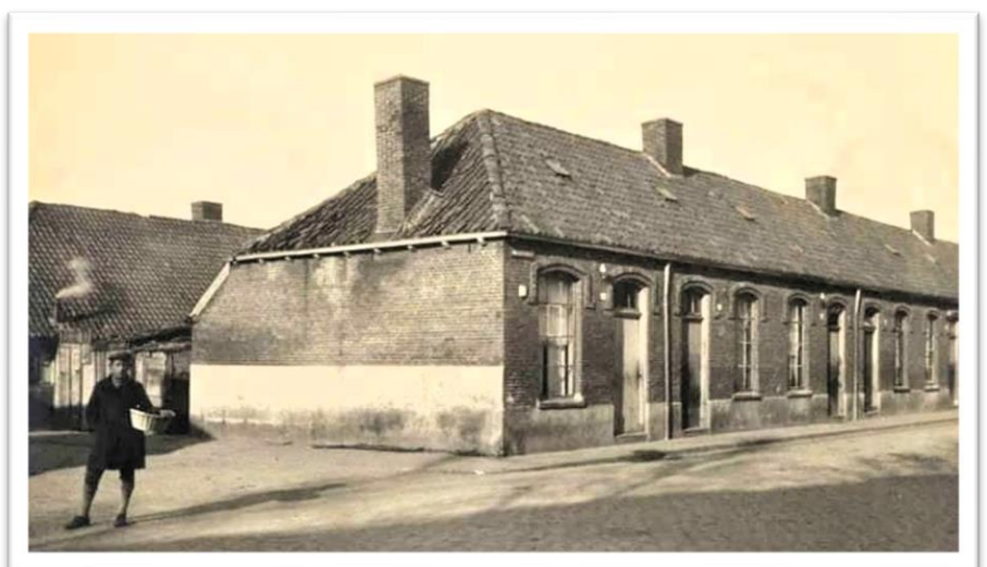
De tweede generatie arbeiders- woningen met een beperkt laag aflopend dak aan de achterzijde. Zo ontstaat meer woonruimte.
