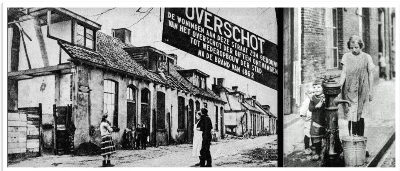
Het Overschot, vlak voor de sloop van de woningen. De drinkwatervoorziening was gemeenschappelijk.
