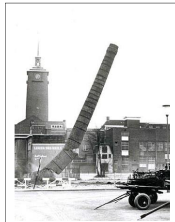
De sloop van de pijp van het ketelhuis zwembad van Heek
