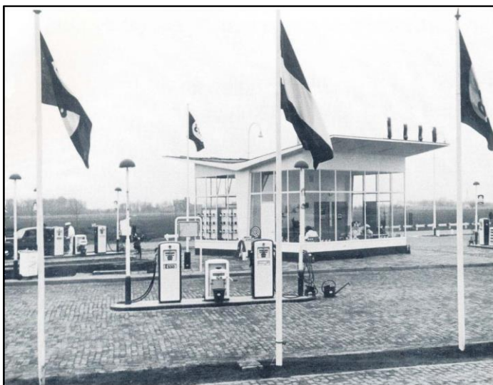
Tankstation aan de Loenersloot naar een ontwerp van architect Dudok; gebouwd in 1950. Foto: Archief Esso.
