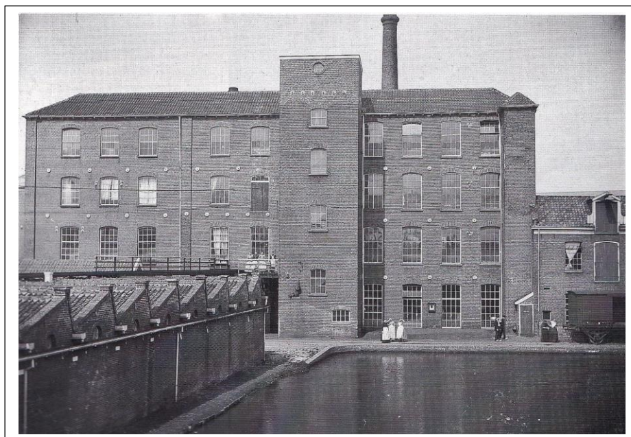
Van Heek in Stadsgaarde omstreeks 1900, een blokvormig gebouw en een weverij met shed daken
