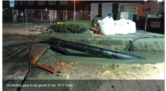
Afb. 2. Aanleg warmtenet
