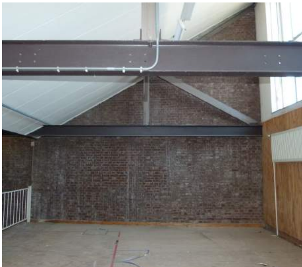
De constructie in de voormalige ververij met zicht op de blinde wand langs de Perikweg en de glaspui aan de Javastraat.
