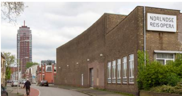
Het volume uit 1938 van de voormalige verrijf met de blinde muur langs de Perikstraat. De vensters endeur zijn een latere toevoeging.
