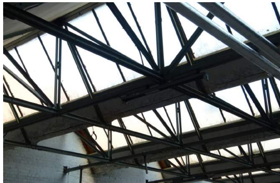
De sheddakconstructie in het deel van 1938. Deze zijn heben nog hun oorspronkelijke vorm en lichtinval.
