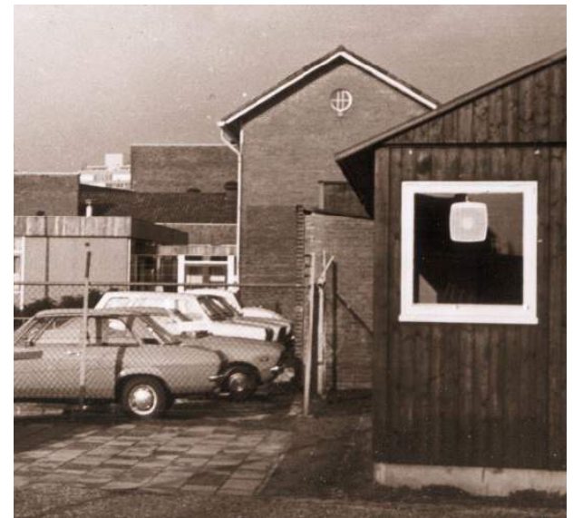
Zicht op de kopse gevel van het kantoorgebouw uit 1950. Rechts een (tijdelijk?) houten paviljoen of loods, 1974 (SAE).
