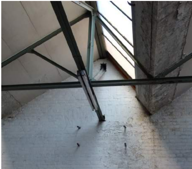
Hier is de open en ook de gesloten zijde van de sheddaken, even als de ijle constructie goed zichtbaar. In de bakstenen (oorspronkelijke buiten)wand is nog een ontlastingsboog herkenbaar.
