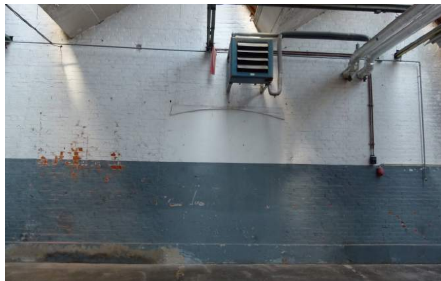
De hal met sheddaken uit 1928 is tegen de buitenmuur van het oorspronkelijke deel uit 1916 plaatst. Dit blijkt ook uit de bouwsporen in de muur, zoals dichtgezette gevelopeningen.
