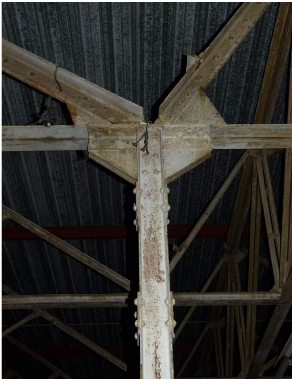
Een deel van de sheddaken zijn aan de buitenzijde niet meer als zodanig herkenbaar door het later aangebrachte golfplaten dak. Hier een van de oudste shedconstructies in het complex.
