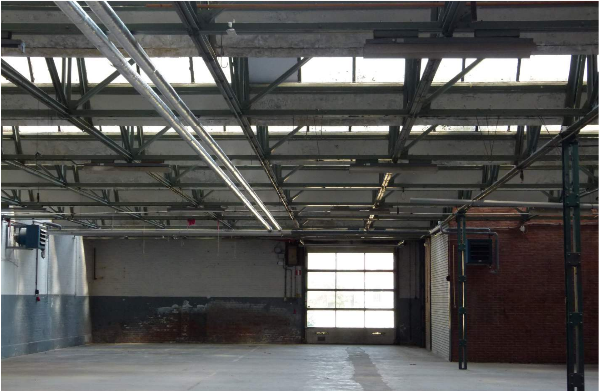
Het volume met sheddaken langs de Floresstraat, gezien richting de Javastraat. Links de oorspronkelijke buitenwand van het eerste volume van de fabriek.
