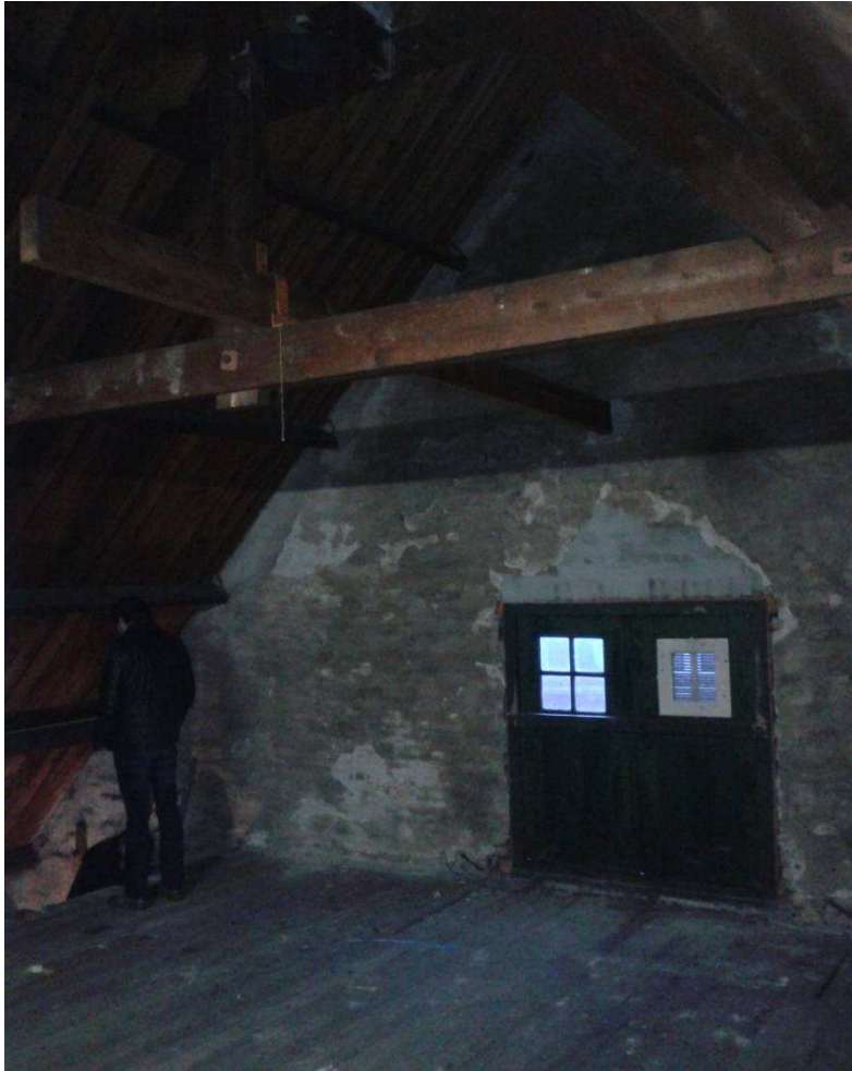
Uitschuifbare balk boven de openslaande deuren van de dakkapel
