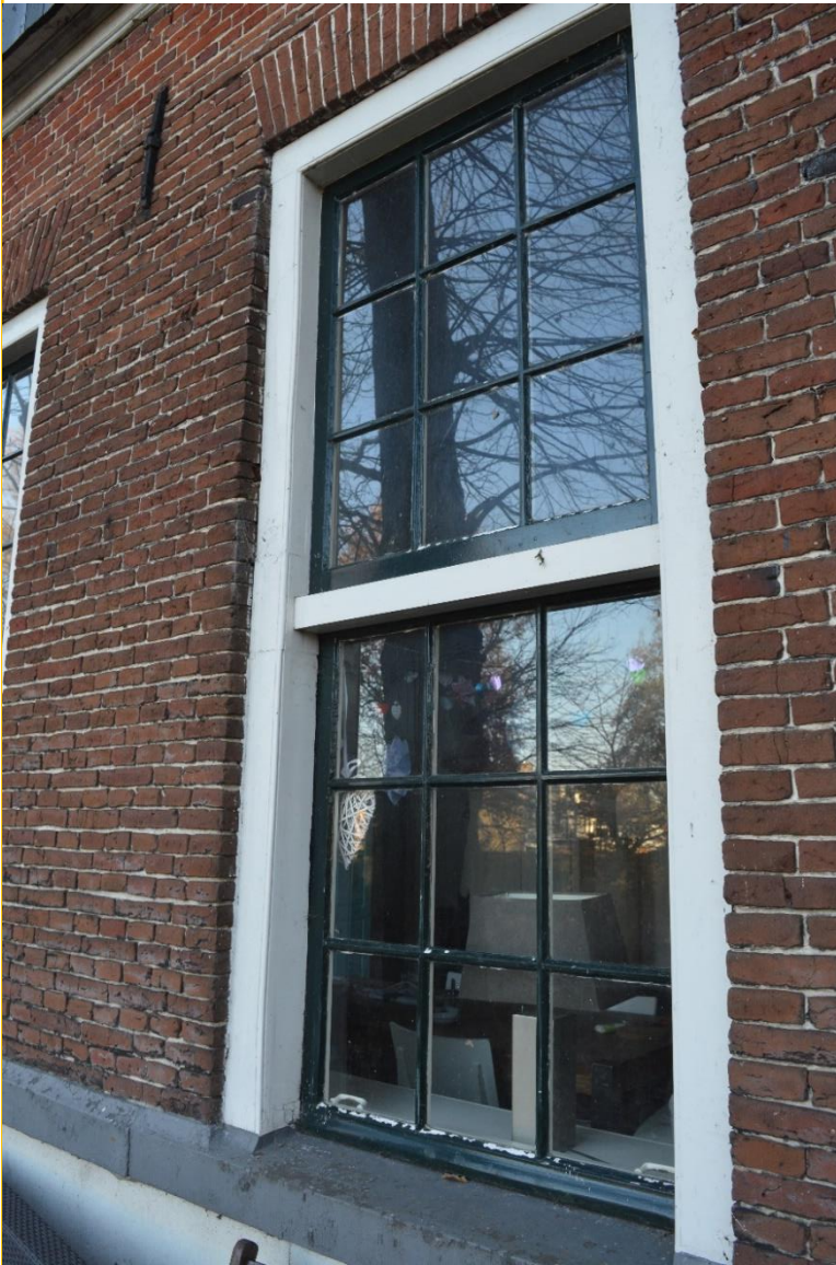
Voorgevel met houten kozijnen en schuiframen met vast bovenlicht.
