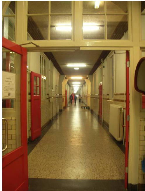
Boven: gang eerste verdieping; terrazzovloer, originele deuren en kozijnen Links: originele inbouwkasten lokaal derde verdieping
