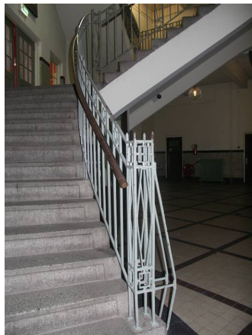
Boven: trappenhuis met trap (granieten traptreden en smeedijzeren traphek) Links: originele betimmering directeurskamer
