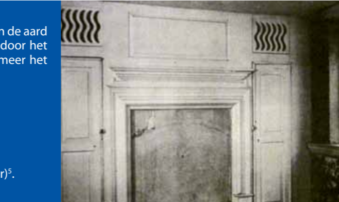
Warmteluchtkanalen naast de (dichtgemaakte) haard; lucht in de 'kasten' wordt opgewarmt door de stenen van het rookkanaal
