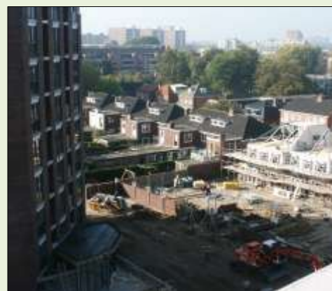
woningen Kneedweg in aanbouw 2006.
