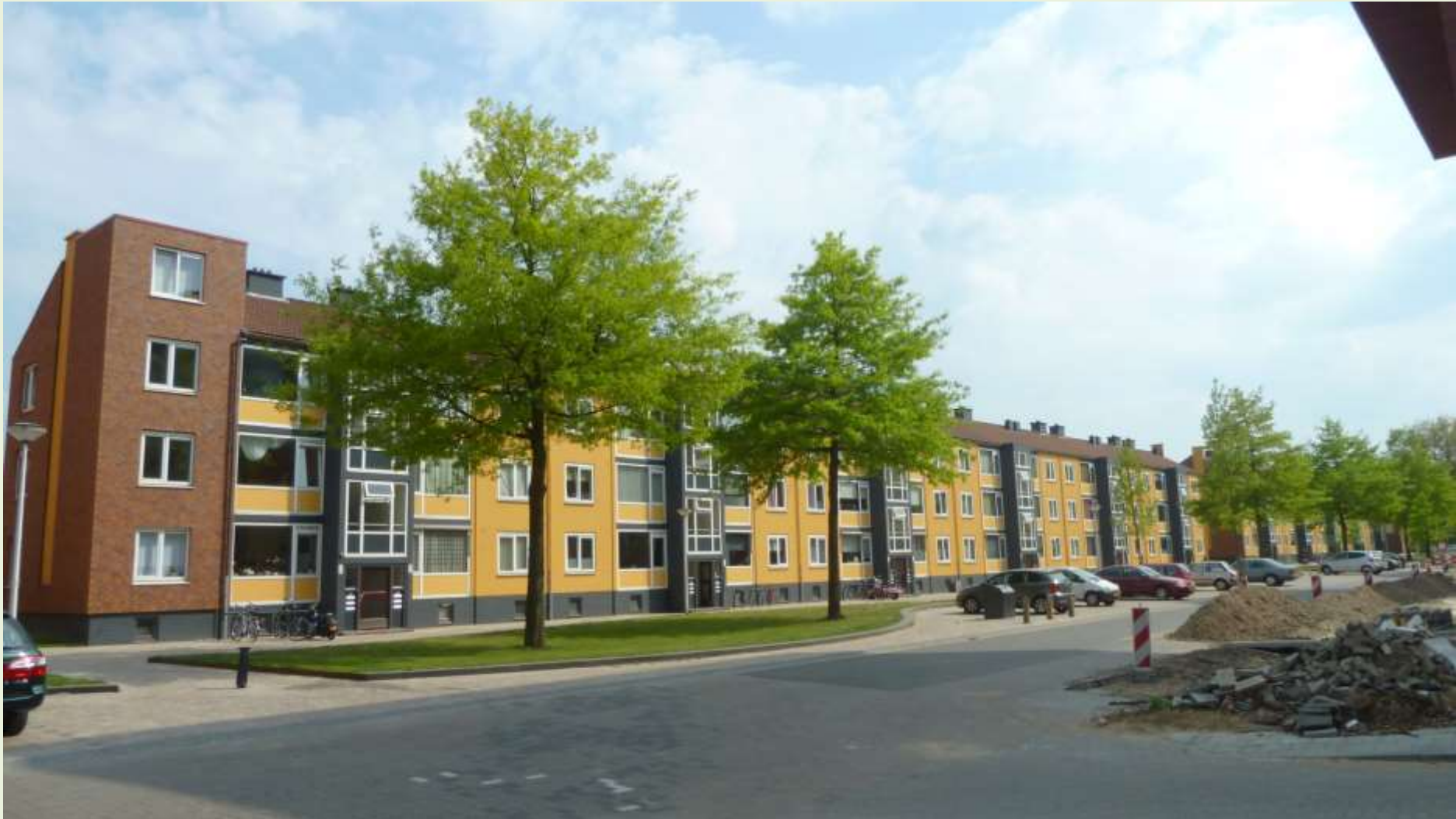
Renovatie van na oorlogse appartementen aan de S.L. Louwesstraat. [2013]
