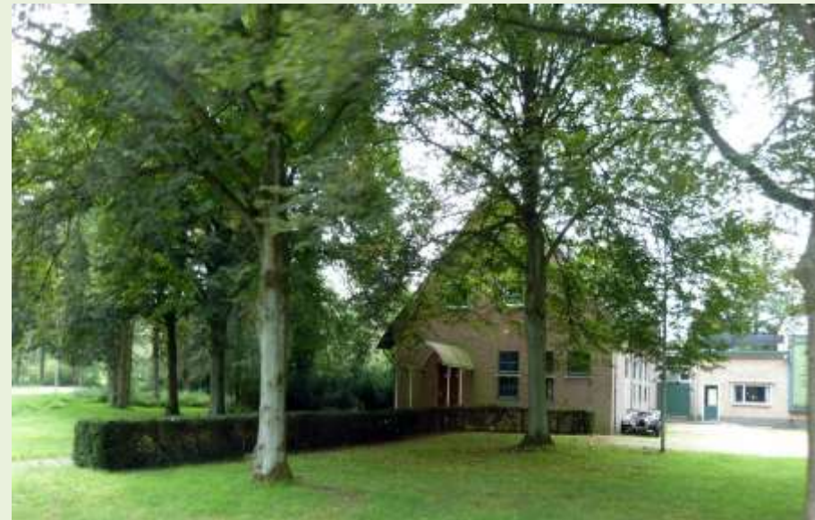
Voormalige eetzaal + centrale keuken voor manschappen.
