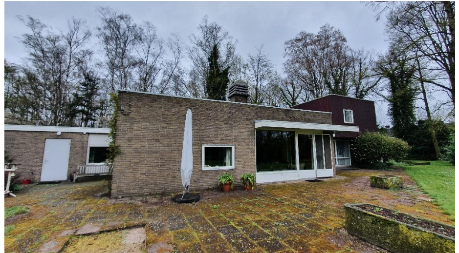
Tuinaanleg en terras aan de west- en zuidzijde, april 2022.
