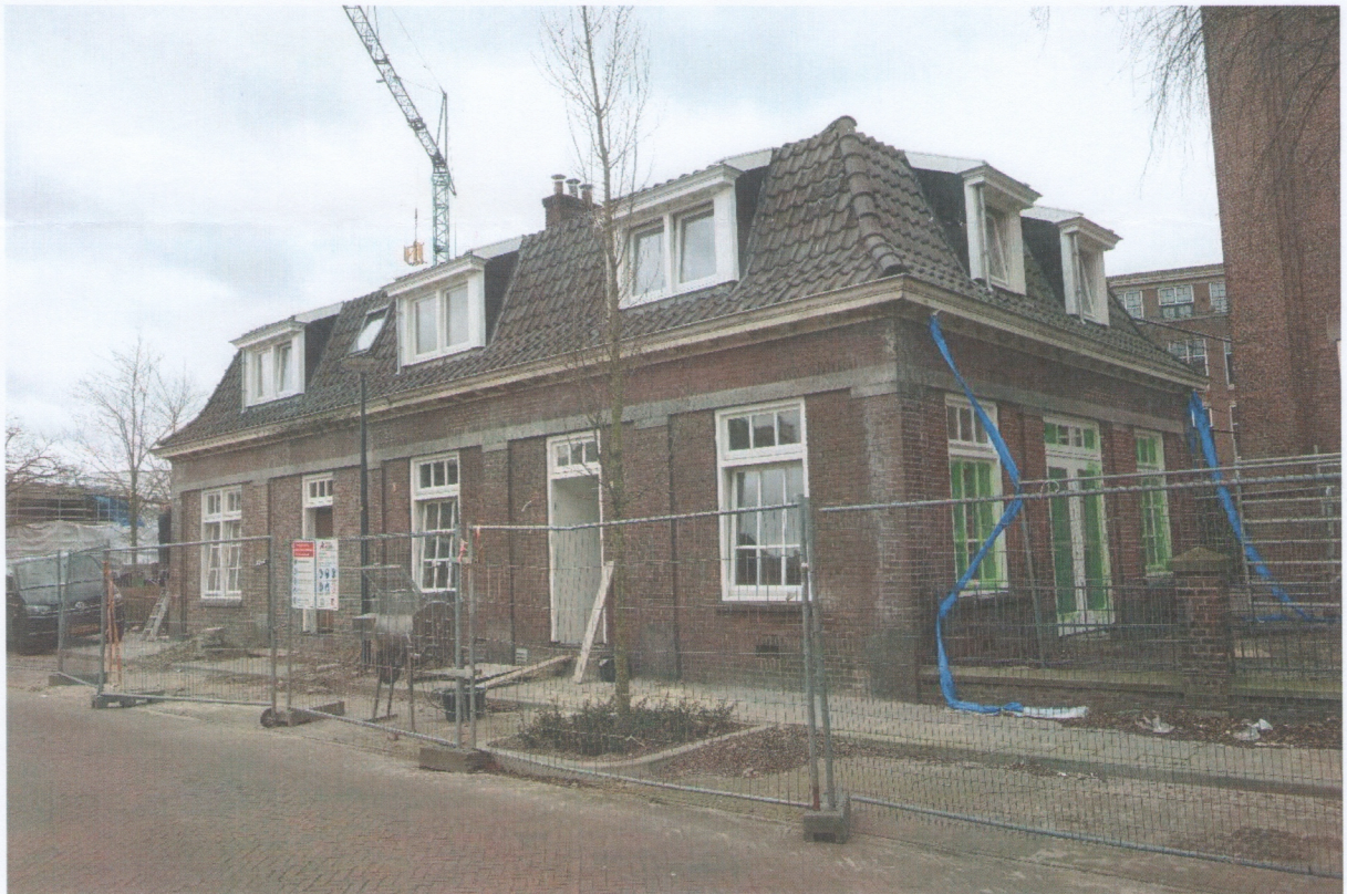
Voorgevel (oost) en rechter zijgevel (noord) in februari 2023.
