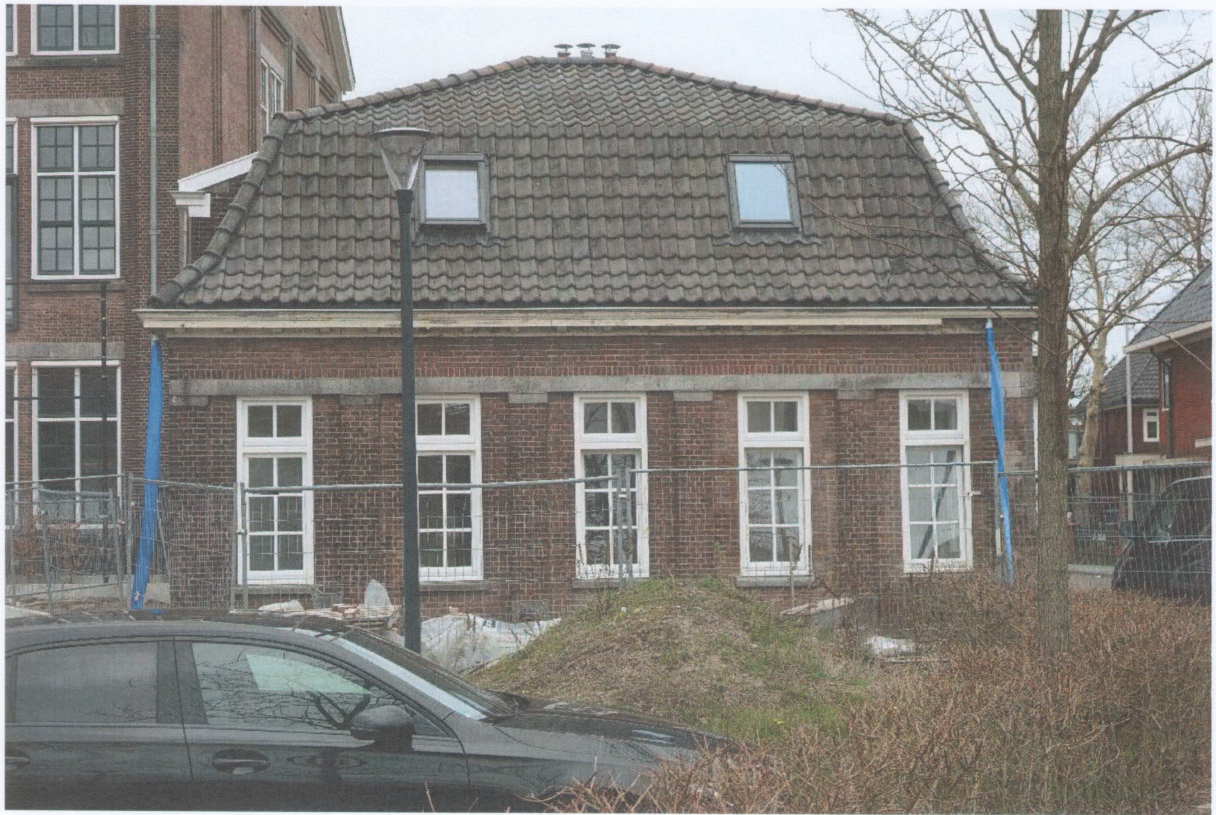
Linker zijgevel (zuid) in februari 2023.
