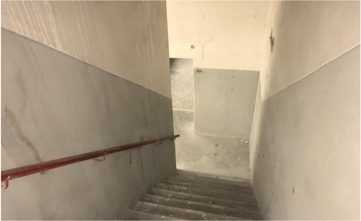
Detail van het trappenhuis in het gebouw 1 uit 1924.
