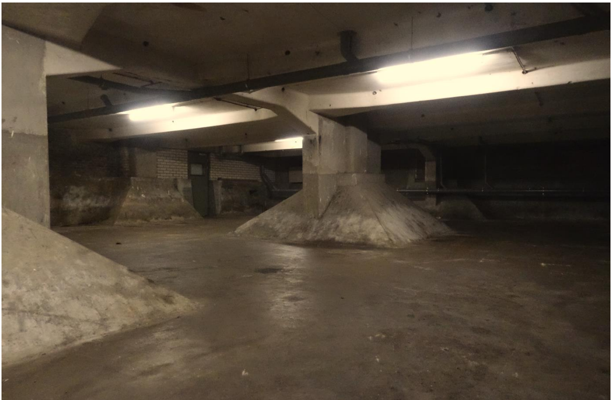
De kelder onder het gebouw 1 uit 1924.
