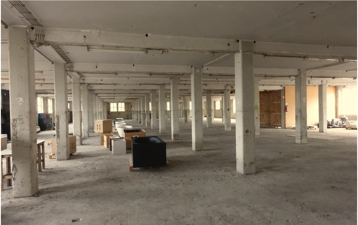
Verdieping met betonskelet in het gebouw 2 uit 1929.
