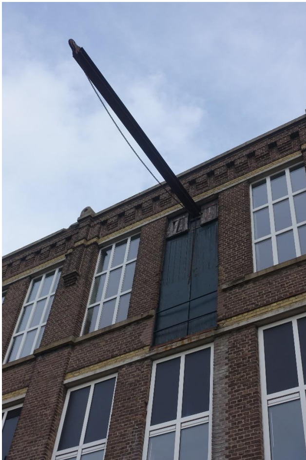
Detail laadluik met hijsbalk in de zuidgevel.
