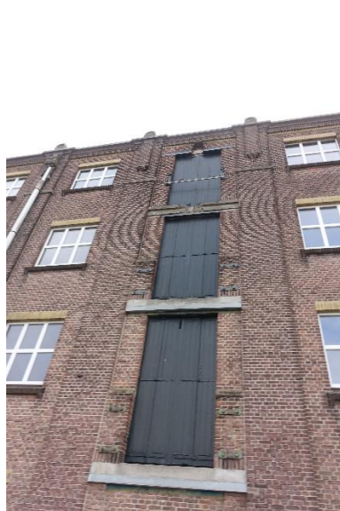
Historische details westgevel: links een ingang met dubbele deuren op de begane grond, in het midden de reeks dubbele laad- en losdeuren op de verdiepingen (middelste travee), rechts de ingang met originele gevelsteen met de naam van het gebouw.
