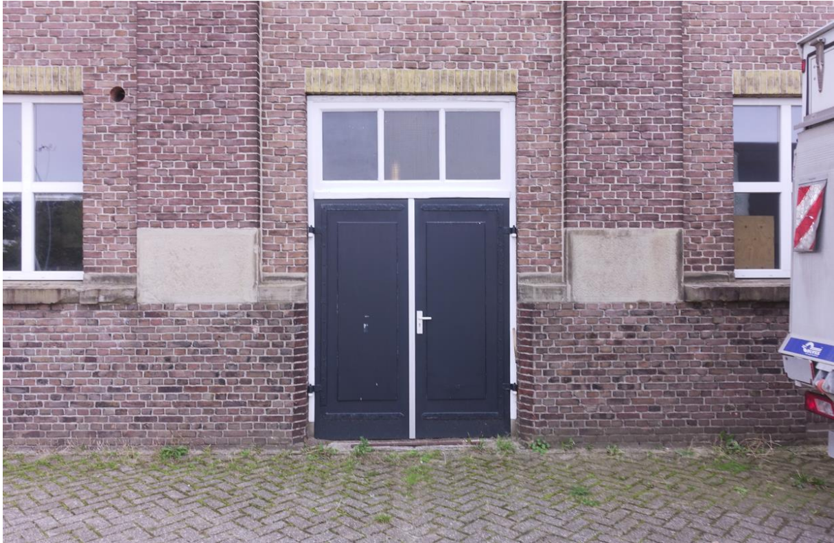
Detail van de oude toegangsdeuren in de lange westgevel van gebouw 2.
