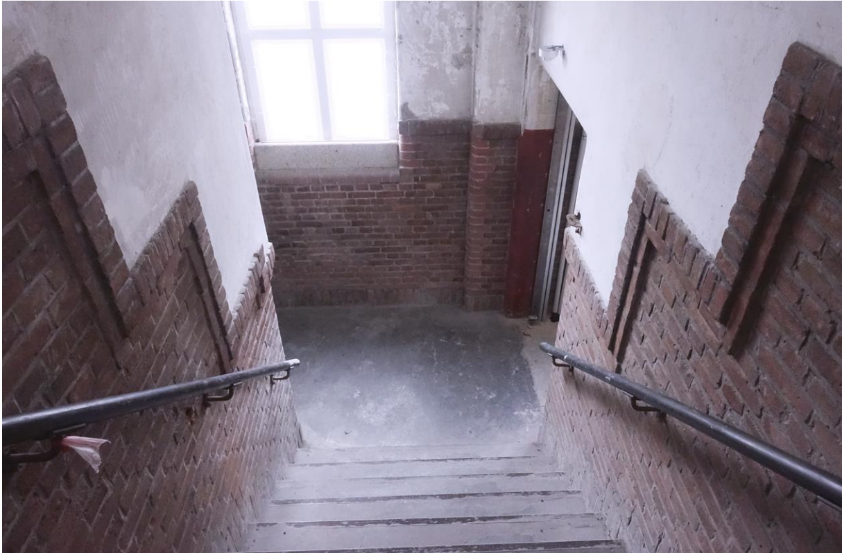
Het trappenhuis aan de zuidwest zijde van het gebouw 2.
