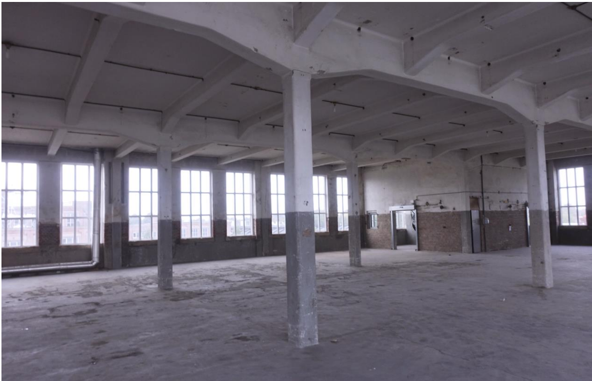
Het betonskelet op de bovenste verdieping van het gebouw 1 uit 1924.
