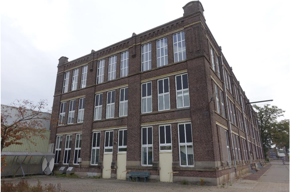
Westgevel van gebouw 1
