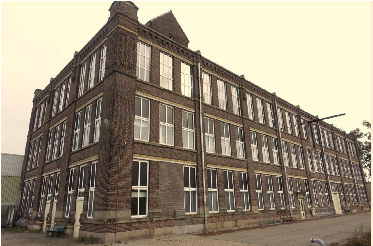
De korte west- en lange zuidgevel van het gebouw 1 uit 1924.
