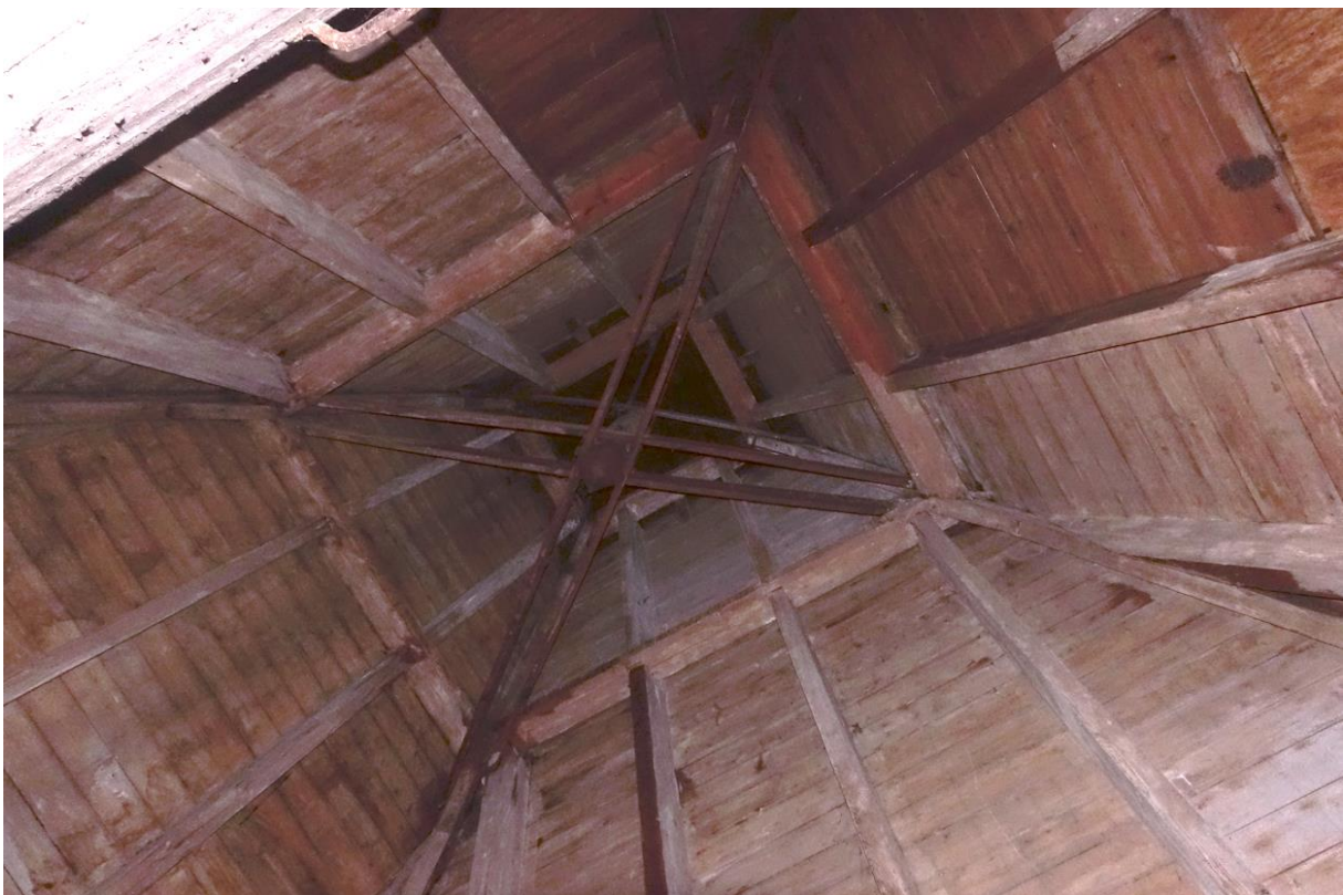
De constructie van de torenspits boven op de toren van het gebouw 2 uit 1929.
