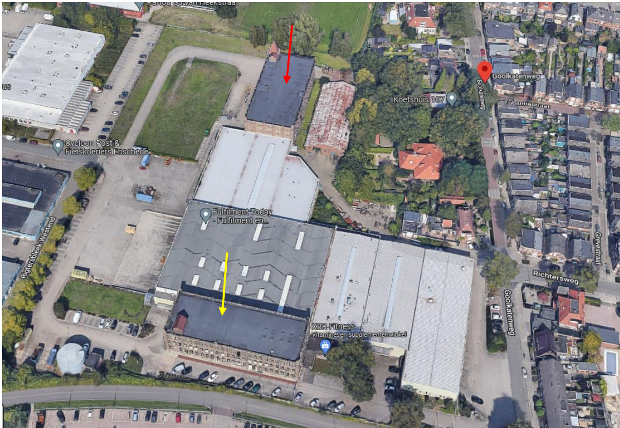
Locatie aanduiding met bij de gele pijl de hal 1 uit 1924 en bij de rode pijl de hal 2 uit 1929.
