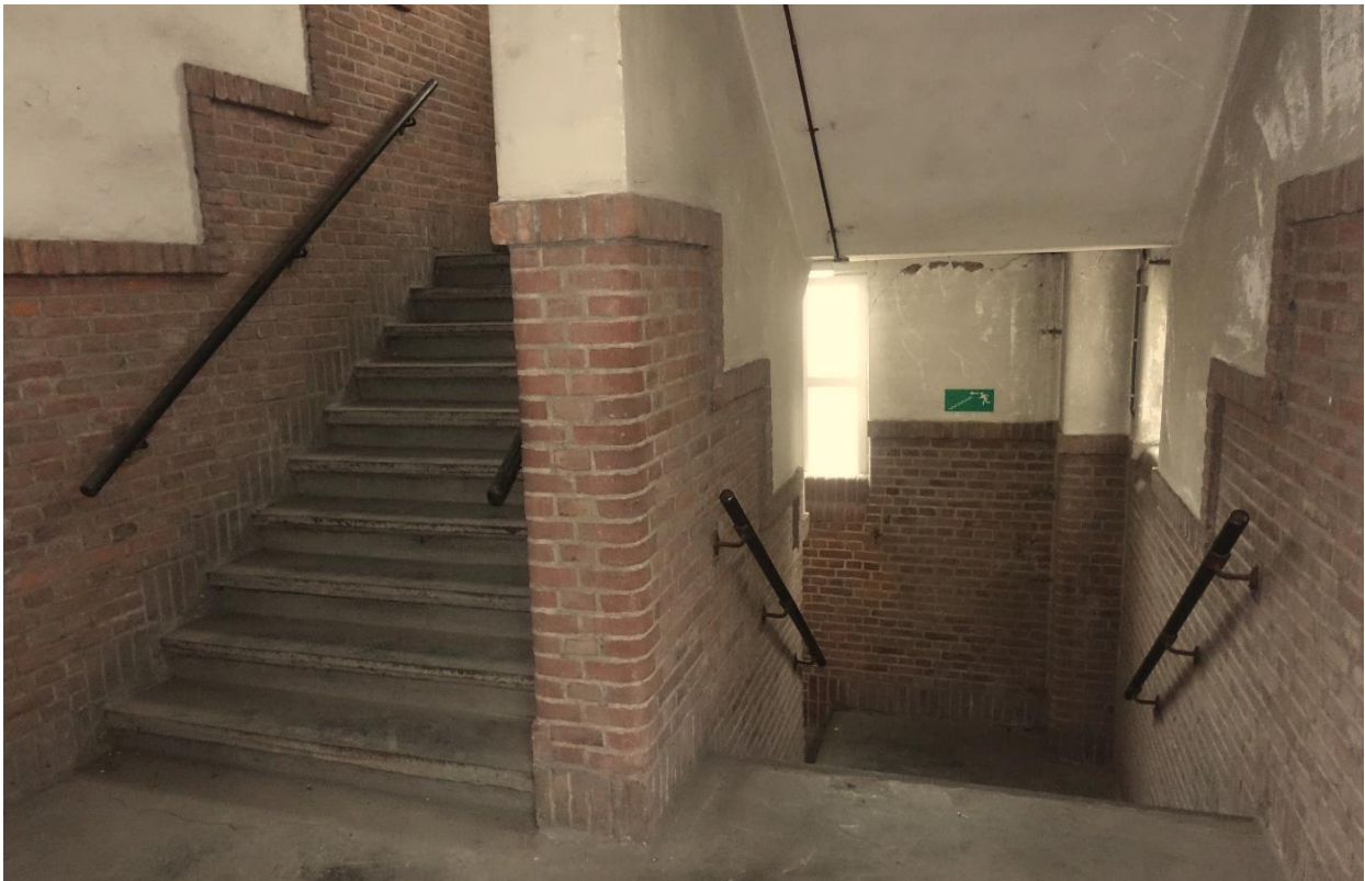
Het trappenhuis in de toren van het gebouw 2 uit 1929.
