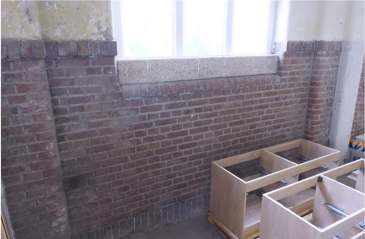
De bakstenen lambrisering op de verdieping in gebouw 2.
