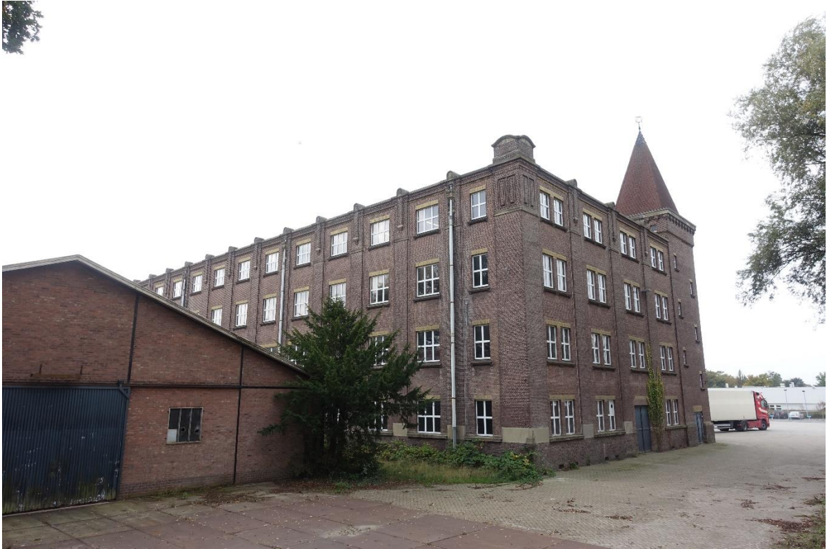
Overzicht oost en noordgevel; uiterst links de uit 1950 daterende vakwerkloods.
