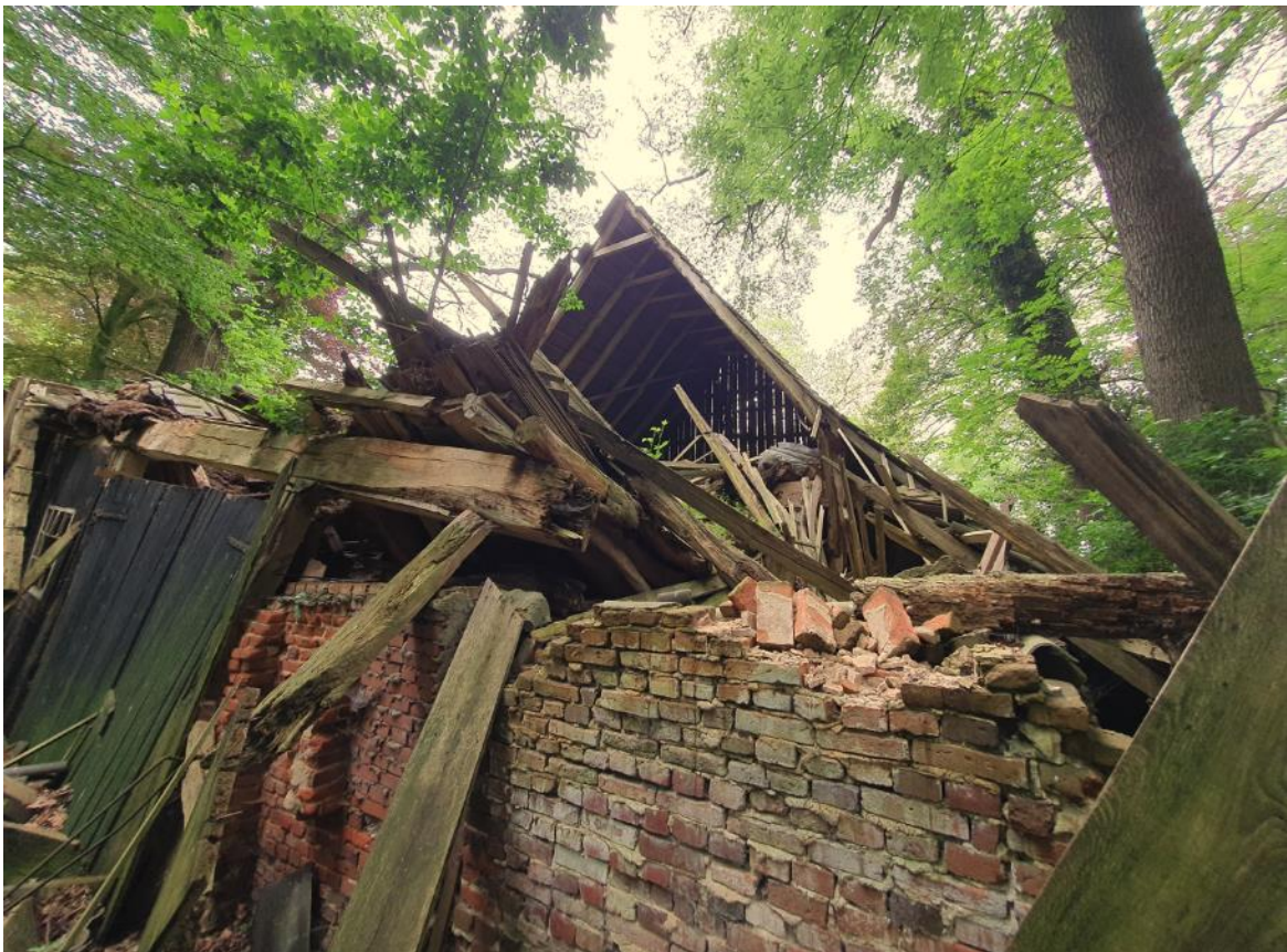
De rechter zijde van de achtergevel van de schuur. Achter de verdwenen houten beschieting is een gemetselde muur aanwezig. Situatie mei 2023. FH MAB 1-6-2023
