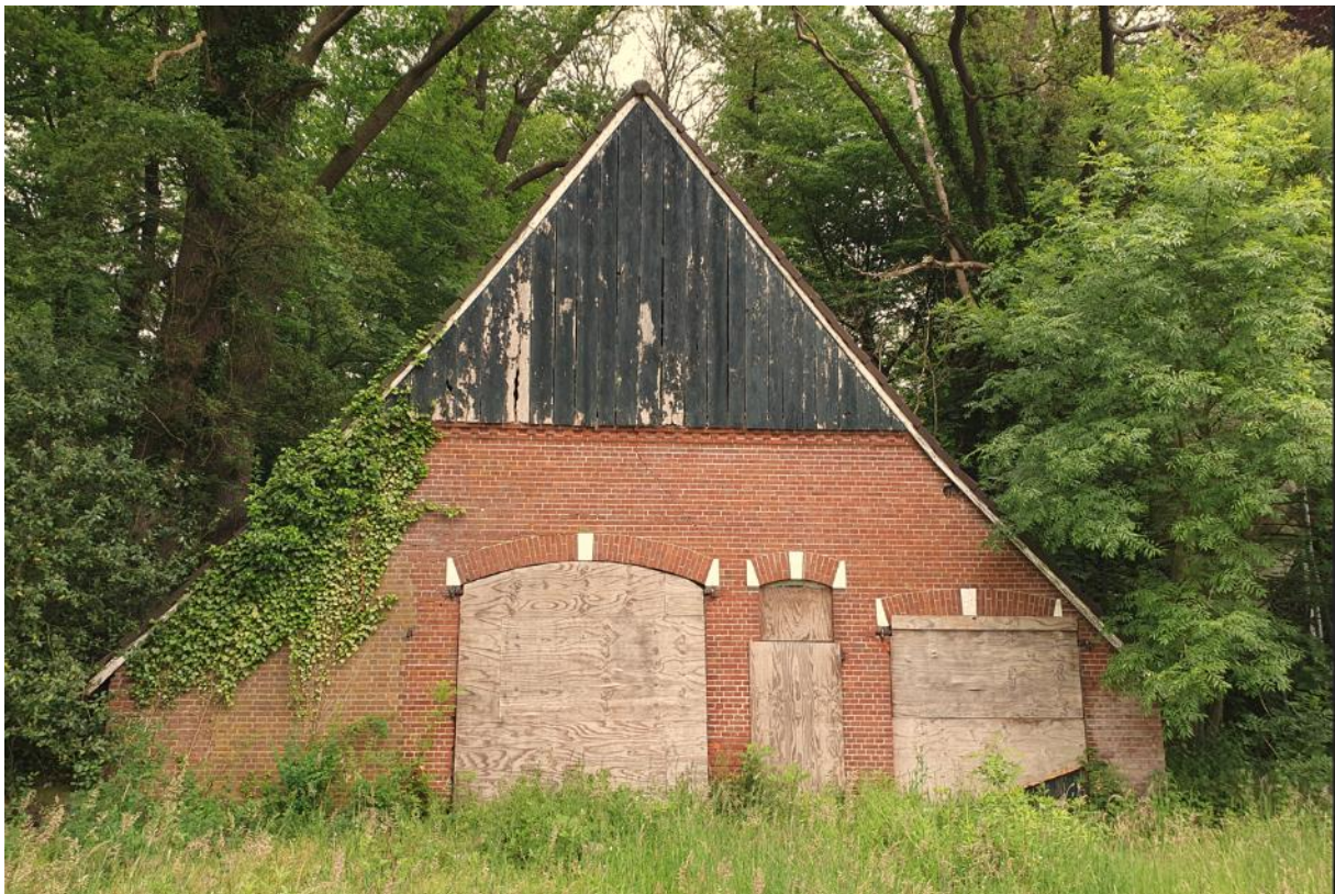
De voorgevel van de schuur. Situatie mei 2023. FH MAB 1-6-2023
