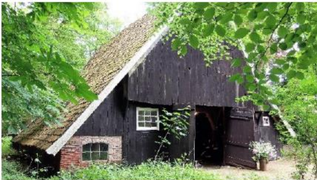
De achtergevel van de schuur voor de instorting.
