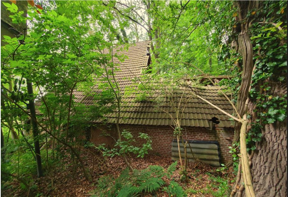
De rechter zijgevel van de schuur. Situatie mei 2023. FH MAB 1-6-2023
