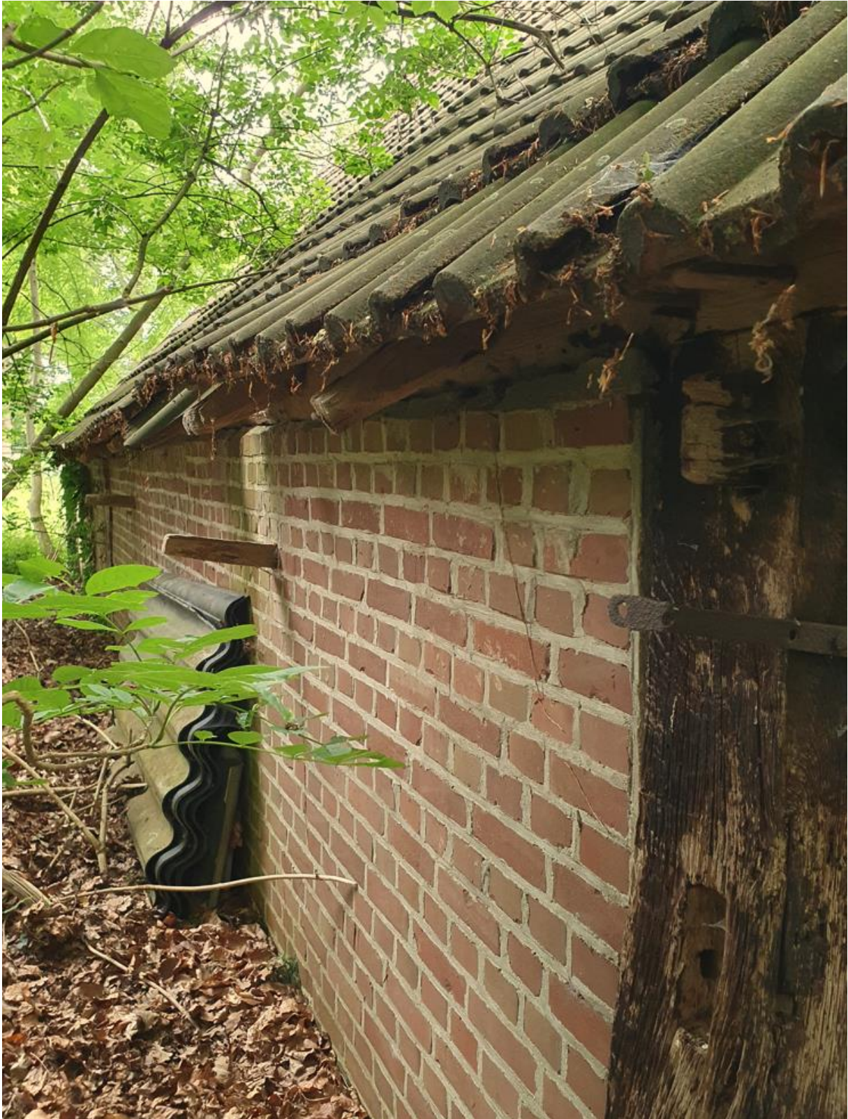
De rechter zijgevel richting voorgevel. Uit de gevel steken twee balkjes, vermoedelijk voor het ophangen van een ladder. Situatie mei 2023. FH MAB 1-6-2023
