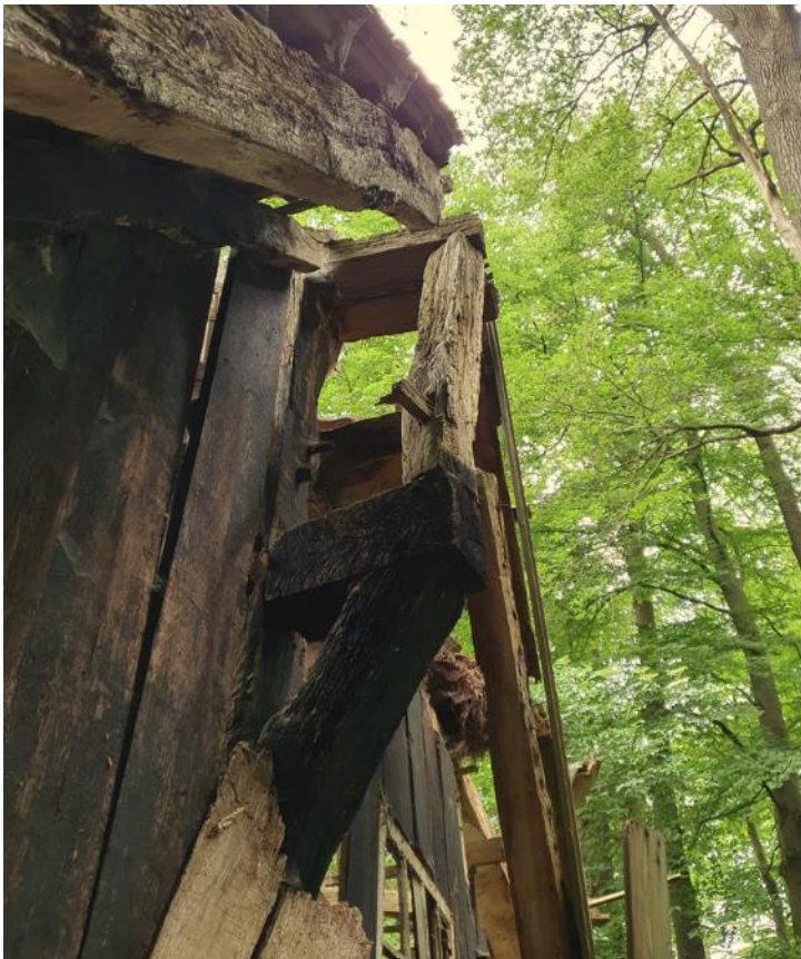
De constructie met korbbeelstel tegen de gebintstijl voor de uitkragende geveltop. FH MAB 1-6-2023
