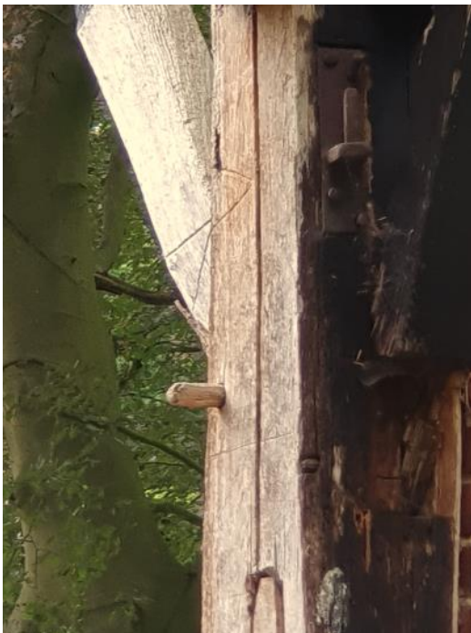
Kleine boerderij, gesneden telmerk V op gebintstijl en windschoor van strijkgebint (links) en gesneden merken IIII en III (gele pijlen) met een doorgehaalde streep op de gebintstijlen aan de rechter zijde naast de doorrit (foto rechts). FH MAB 1-6-2023
