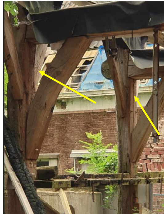
Kleine boerderij, gesneden telmerk V op gebintstijl en windschoor van strijkgebint (links) en gesneden merken IIII en III (gele pijlen) met een doorgehaalde streep op de gebintstijlen aan de rechter zijde naast de doorrit (foto rechts). FH MAB 1-6-2023
