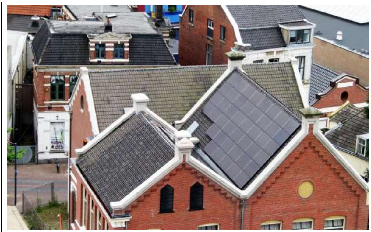
Het dak van de voormalige Fabrieksschool belegd met zonnepanelen.
