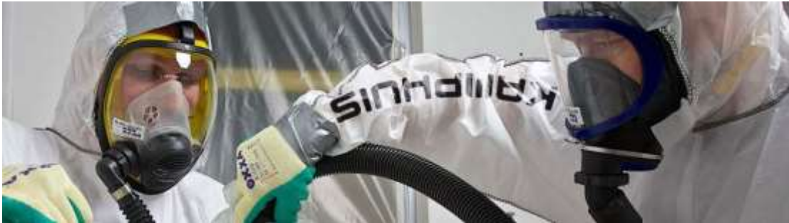
Foto; Kamphuis asbestsanering.
