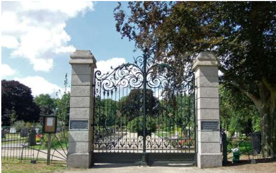
Toegangspoort begraafplaats Usselo is een gemeentelijk monument.
