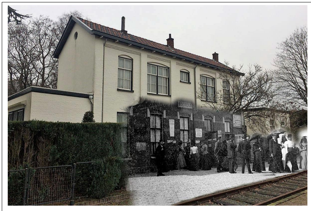
Voormalig stationsgebouw Boekelo [fotograaf onbekend]
